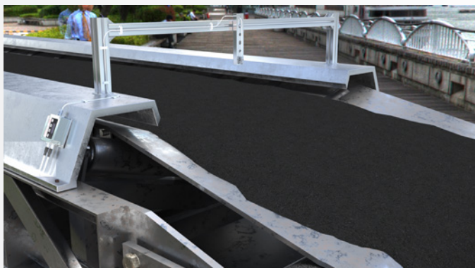
Contrôle de la température de traitement lors du chargement d'asphalte avec thermoMETER UC
